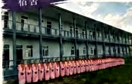
第一期工程2025年中宿舍已建造完成
